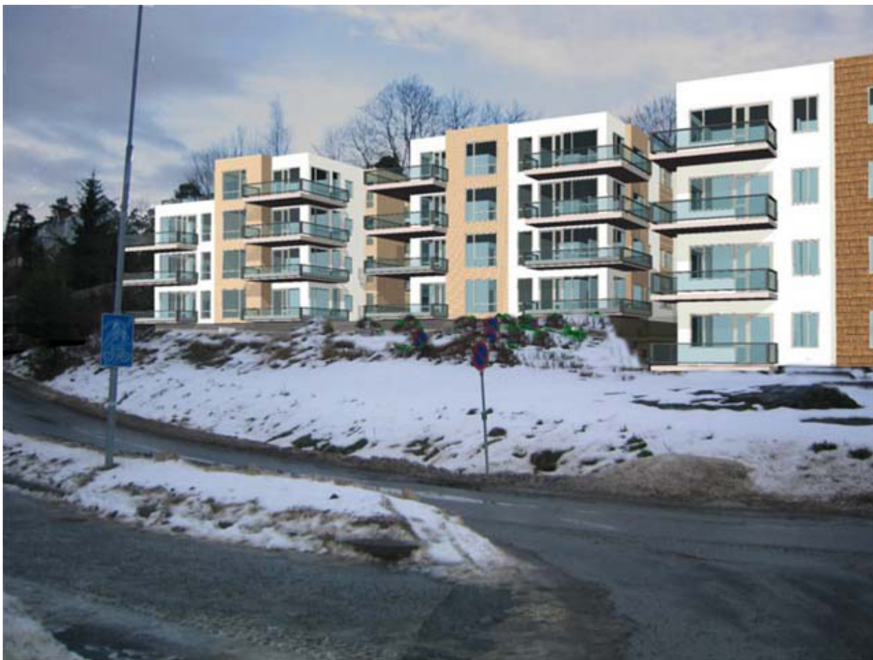
Oversiktsbilde sett fra Strasjonsveien.
